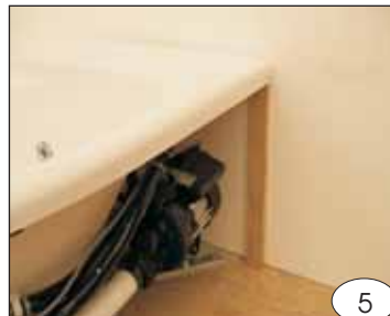
5 Il est bien d'appuyer le bord du tablier sur une cale fixée au mur. Es ist empfehlenswert, den Rand der Schürze auf einen an der Wand fixierten Keil zu setzen.
