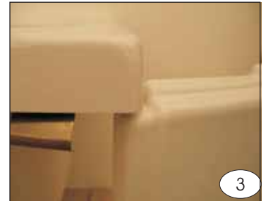
3 Mettre la baignoire à hauteur du tablier, régler à l'aide des pieds. Mit Hilfe der Füße die Wanne auf die Höhe der Schürze bringen.
