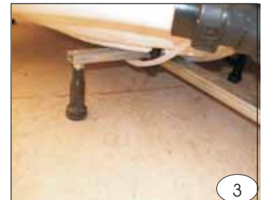
3 Régler la hauteur à l'aide des pieds réglable. Le tablier reste libre. Höhe durch Regulieren der Füße einstellen. Schürze noch nicht anbringen.
