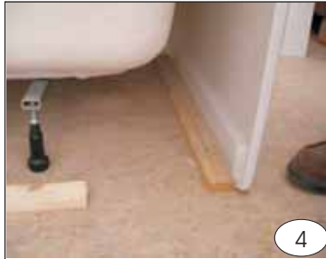
4 Appuyer le bas du tablier sur des cales fixées au sol. Schürze auf am Boden fixierten Keil stellen.
