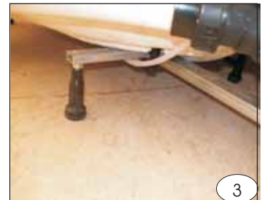
3 Régler la hauteur à l'aide des pieds réglable. Le tablier reste libre. Höhe durch Regulieren der Füße einstellen. Schürze noch nicht anbringen.
