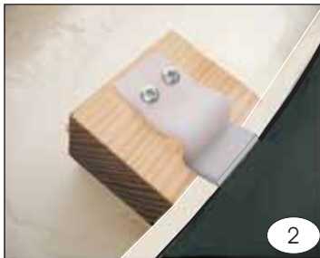
2 Aperçu de la baignoire avec les pattes fixées. So sieht die Wanne mit den fixierten Stützen aus.
