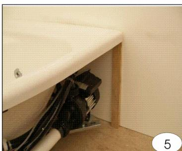
Il est bien d'appuyer le bord du tablier sur une cale fixée au mur.
