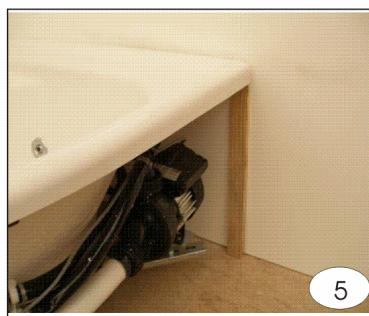
Il est bien d'appuyer le bord du tablier sur une cale fixée au mur.
