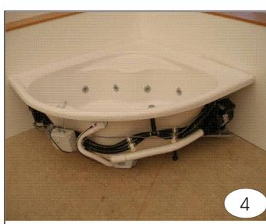
Mise en place de la baignoire. Contrôle avec niveau.
